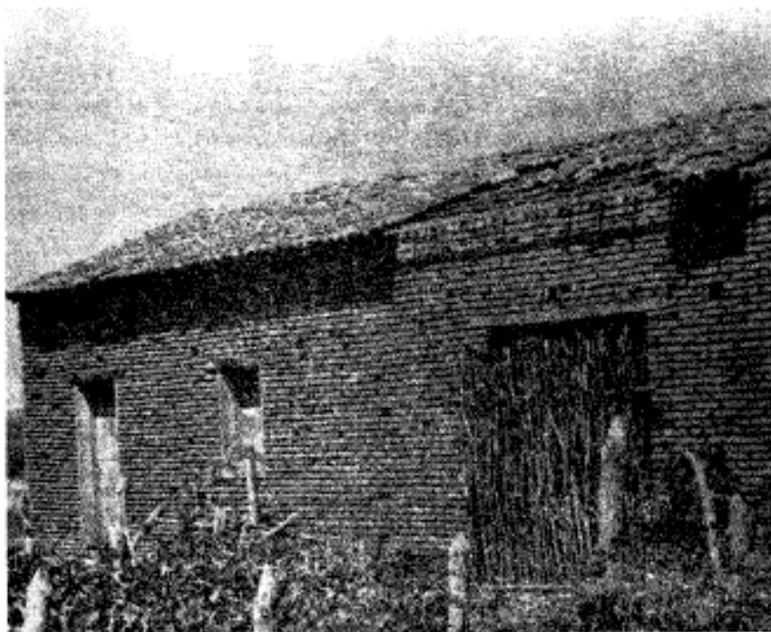
Início da expulsão da terra: destelhamento.
